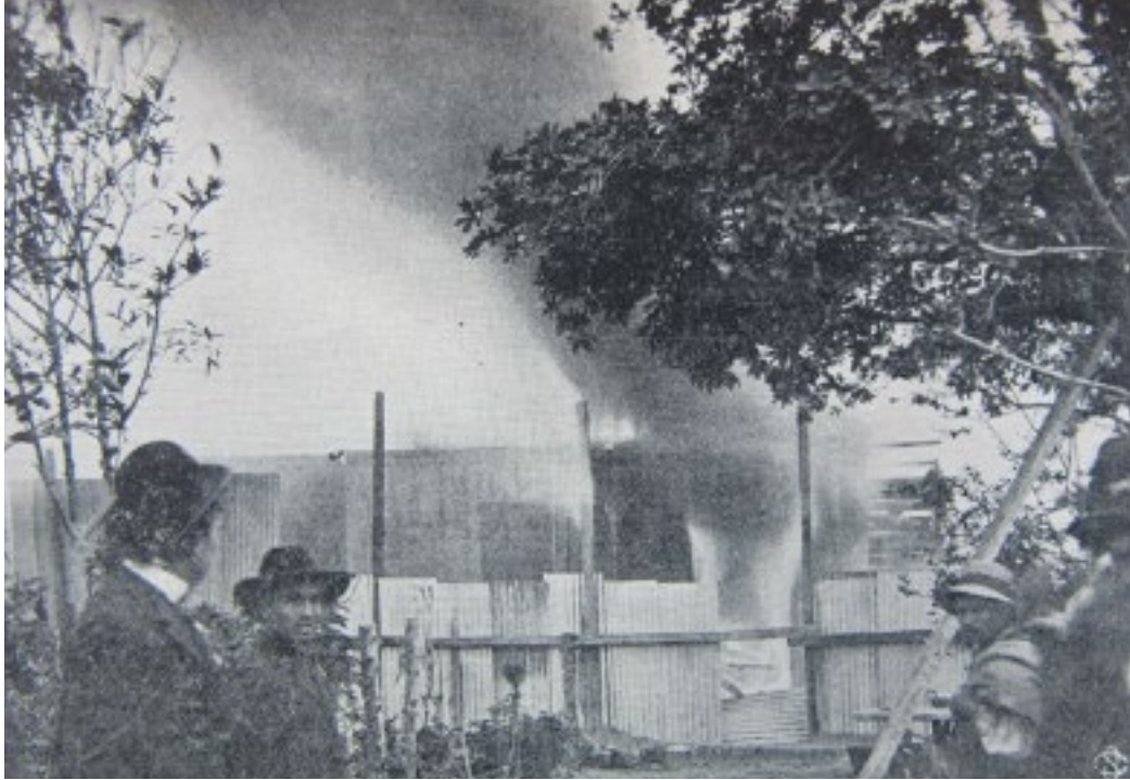
Figura 3. Incendio de casa de “apestados” de Mollendo
