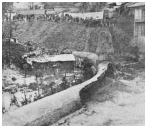
Imagen 9. Inundación en la desembocadura de la quebrada San Bruno con el río San Francisco
