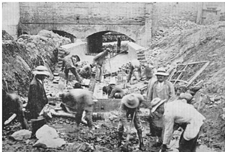
Imagen 5. Puentes de Arrubla y Caldas en la Avenida Jiménez: construcción entre la carrera 7ª y la 8ª
