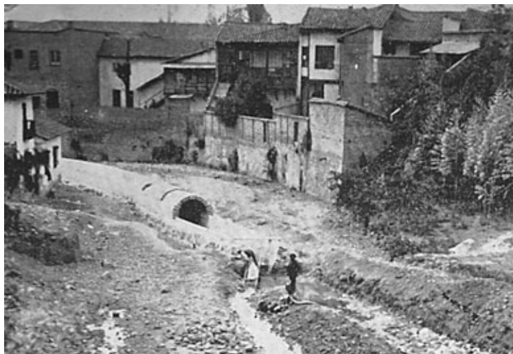
Imagen 6. Colector del río San Francisco: antes de la canalización los frentes de las casas daban la espalda al río
