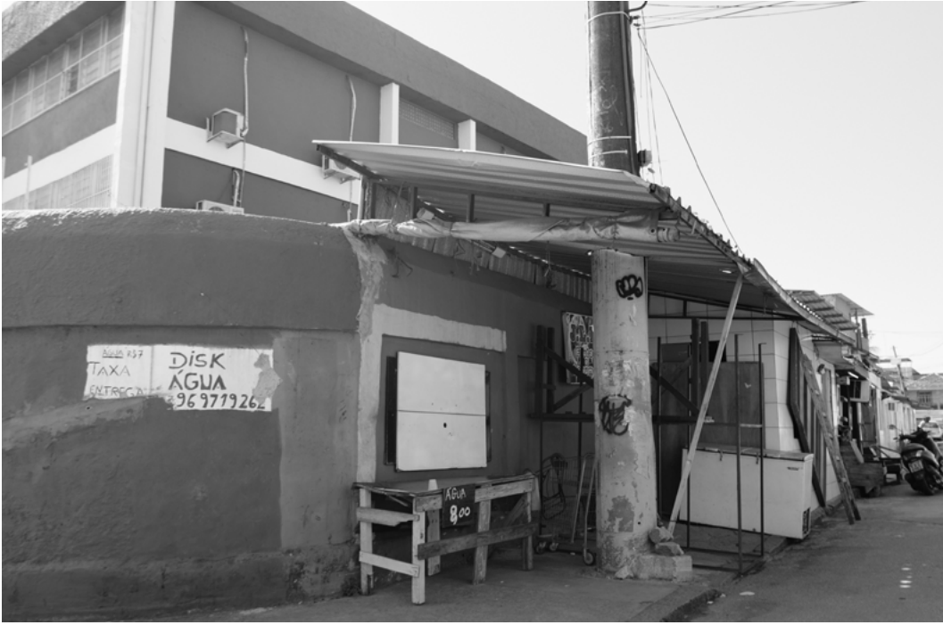
Figura 2. Apropiación informal del muro de una escuela pública
