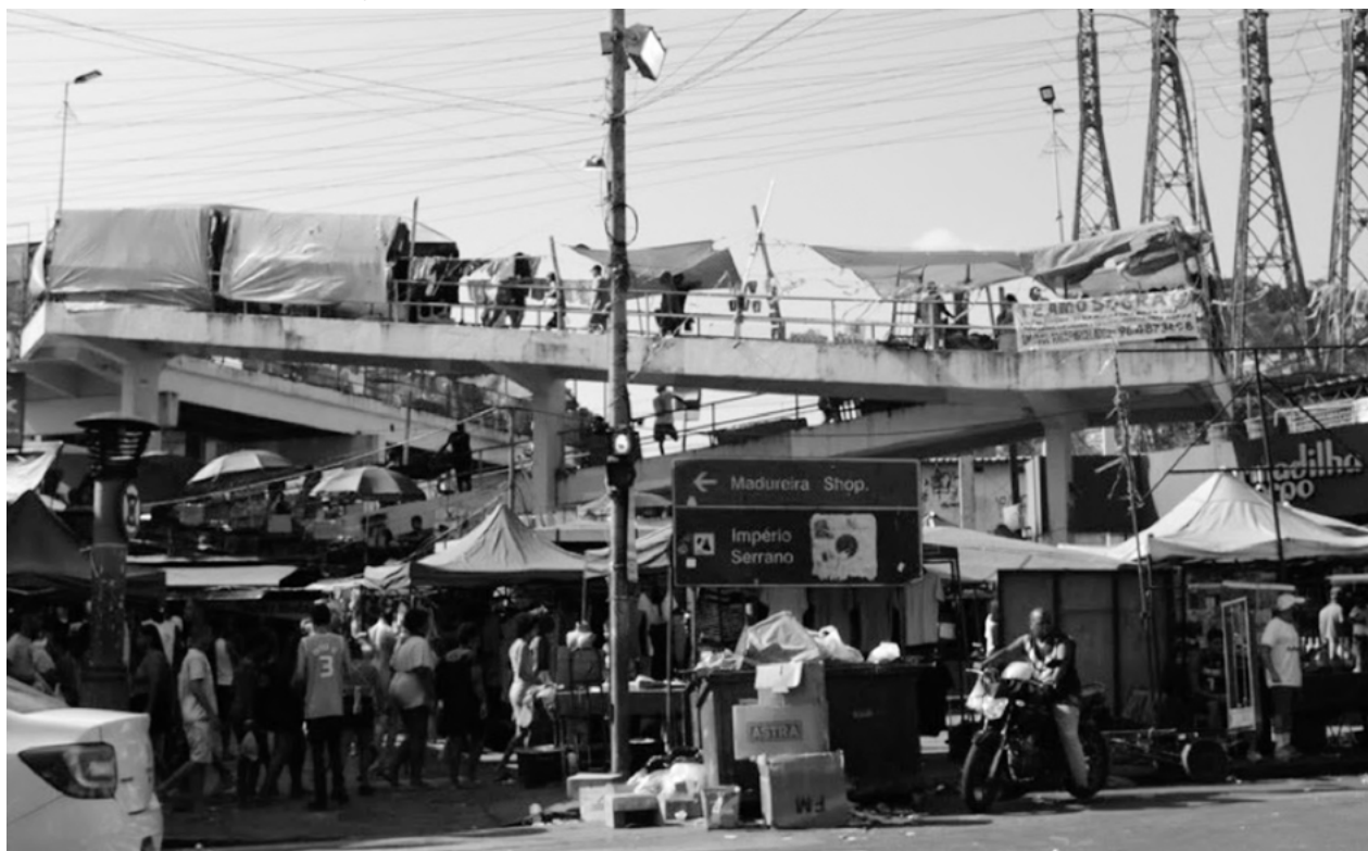
Figura 1. Pasarela de la Estación de Mercadão, Madureira
