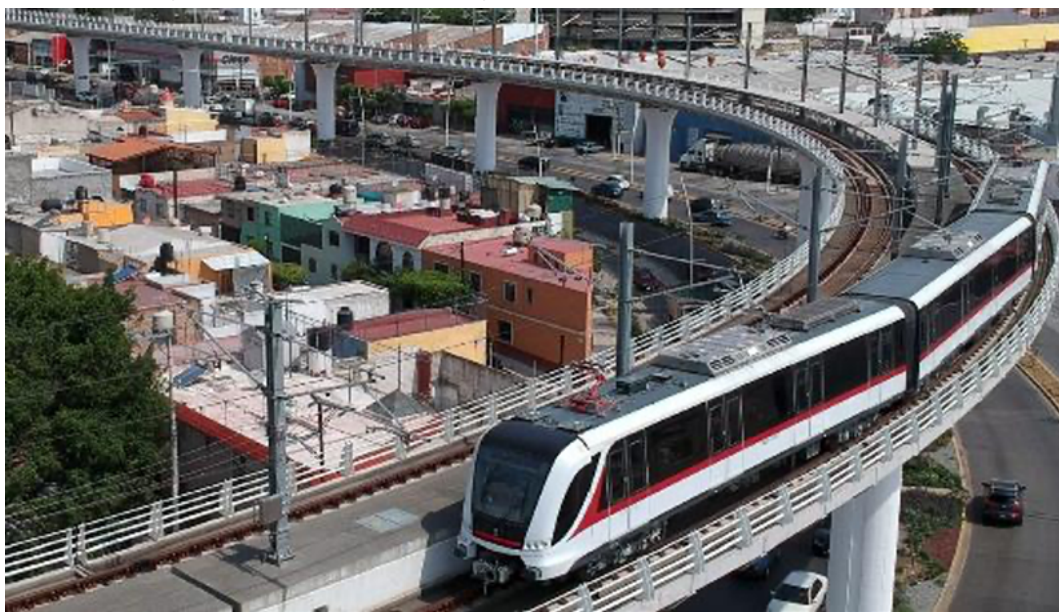
Figura 1. Línea 3 del Tren Ligero de Guadalajara en funcionamiento
