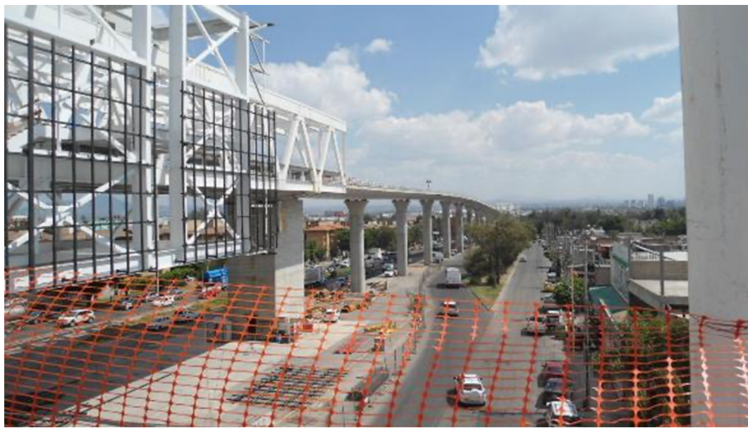
Figura 4. Construcción del viaducto 1 de la L3 de Guadalajara
