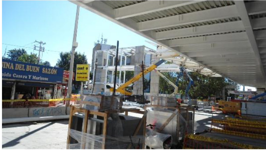
Figura 8. Escena cotidiana durante la construcción de infraestructura de transporte
