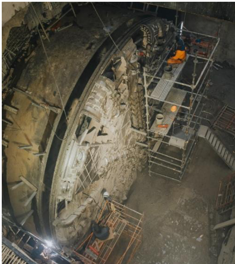
Figura 6. Imagen de la tuneladora “La Tapatía”
