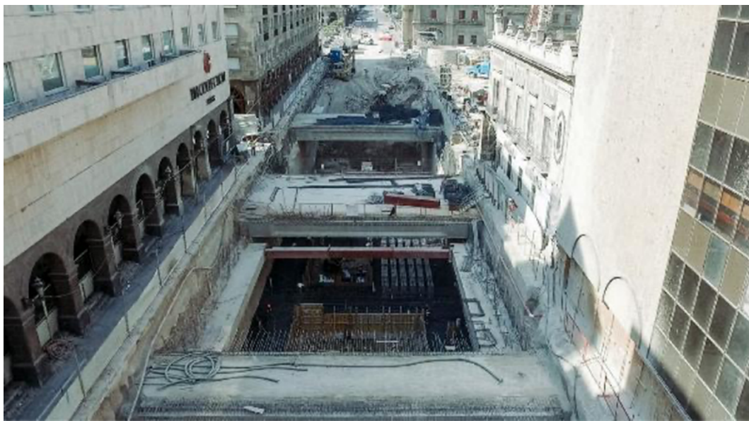
Figura 7. Vista de los trabajos del túnel en la avenida Alcalde, una de las principales avenidas del centro de la ciudad
