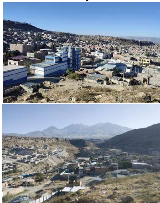
Figura 5. Contraste de construcciones en áreas de riesgo medio alto
